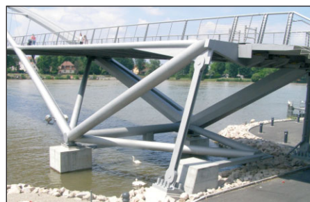
Fig. 7: Weil am Rhein: free for longitudinal displacement
