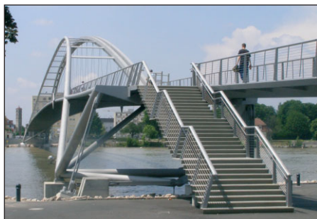
Fig. 9: Ramp Weil am Rhein
